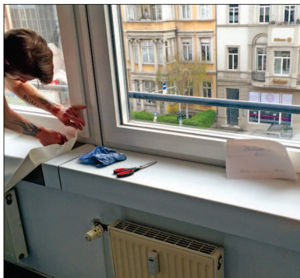
Im Gebäudeinneren verklebte das Team auch die Fensterbänke.
